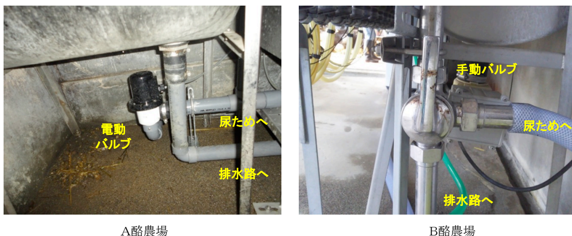
図5 前すぎ排水の分離処理の施工状況
